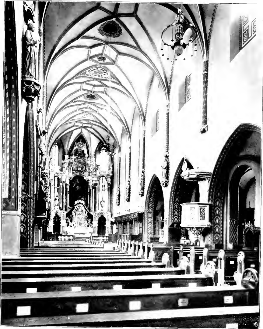
STADTPFARRKIRCHE AICHACH, RESTAURIERUNG
